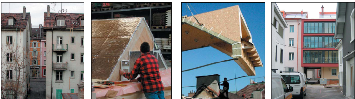
Figur 2: Passivhausrenovation einer Altliegenschaft mit vorgefertigtem Dachstock (Arch. K. Viridén, Zürich) [39]; v.l.n.r.: (1.) Die Liegenschaft vor der Renovation, (2.) Vorfabrikation des Dachstuhls mit Vakuumisolation, (3.) Montage des Dachstuhls, (4.) Die renovierte Liegenschaft: nahe am Minergie-P-Standard für Neubauten
