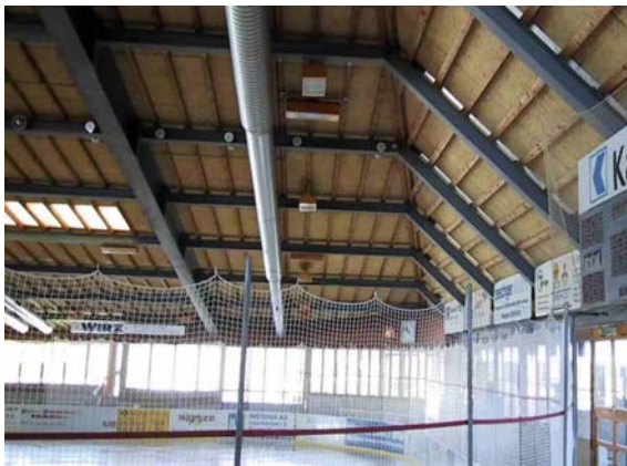
Figur 1: Zustand vor Sanierung mit Faserholzdecke Figur 2: Neuinstallierte Aluminium-Deckenuntersicht
