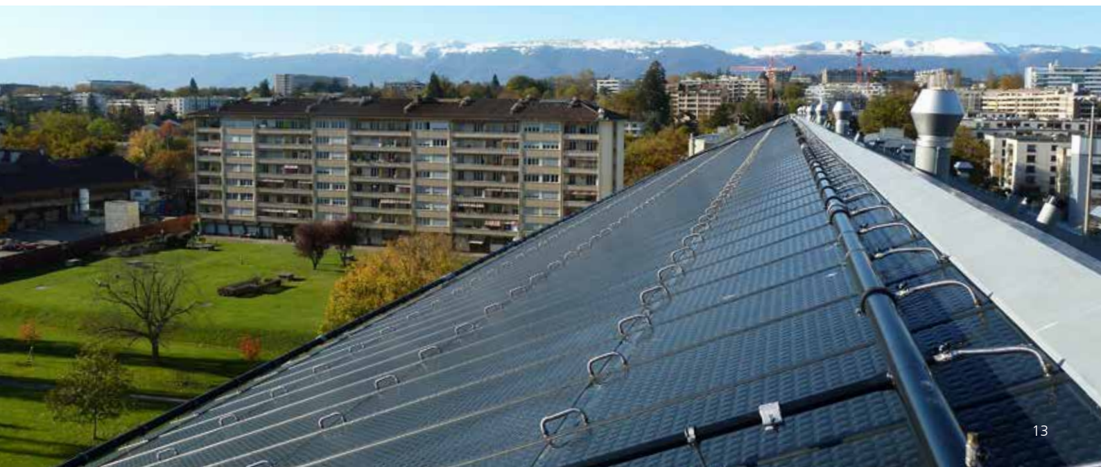
Solarthermische Anlage auf zwei Wohnblocks in Genf mit insgesamt 273 Wohnungen und einer Energiebezugsfläche von 19'000 m 2 .
