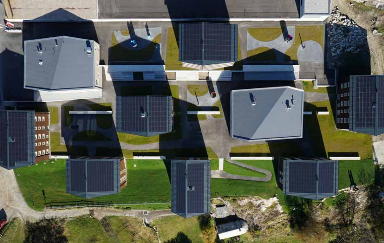
REKA-Ferendorf in Blatten (VS): Die Dächer sind nach Westen und nach Osten ausgerichtet, so dass der solare Ertrag insbesondere am Morgen und am Nachmittag anfällt, dann wenn im Feriendorf die Belastungsspitzen auftreten.
