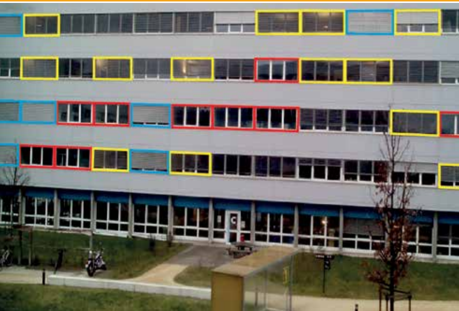
Westfassade eines Bürogebäudes mit manuell bedienten Storen an einem bedeckten Tag: Die Nutzung der Storen erfolgt zufällig und nur ein Teil befindet sich in zweckmässiger Position (rot). In einigen Büros brennt Licht, während die Storen teilweise heruntergelassen sind (gelb).
