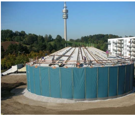
Montagefuge zur Aufnahme der Montagetoleranzen (2 Stück). Innen mit Edelstahlblech
