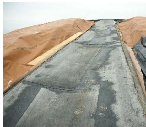
Schließen des Speicherdeckels mit zwei gegenüber liegenden Sonderfertigteilen zur Aufnahme der Vorspannanker.
