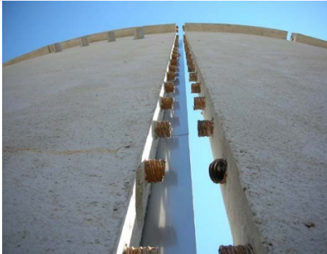
Montagefuge zur Aufnahme der Montagetoleranzen (2 Stück). Innen mit Edelstahlblech
