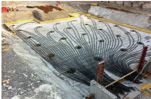
Abbildung 9: Sondenfuss einer Erdwärmesonde (Janssen AG) und Erdwärmesonden-Feld mit Anbindeleitungen vor Einbettung in Betonschutzhülle
