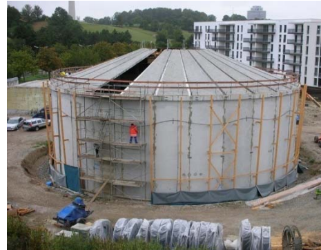
Schließen des Speicherdeckels mit zwei gegenüber liegenden Sonderfertigteilen zur Aufnahme der Vorspannanker.
