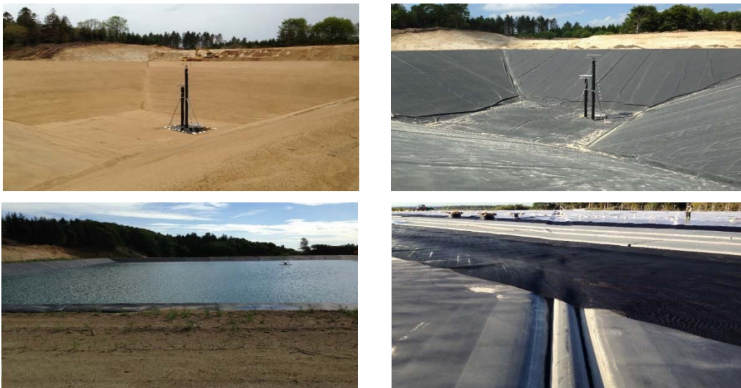
Abbildung 8: Dokumentation des Baus des Erdbecken-Wärmespeichers in Dronninglund mit 60.000 m 3 Wasservolumen (Fertigstellung 2013) (Quelle: Dronninglund Fjernvarme)
