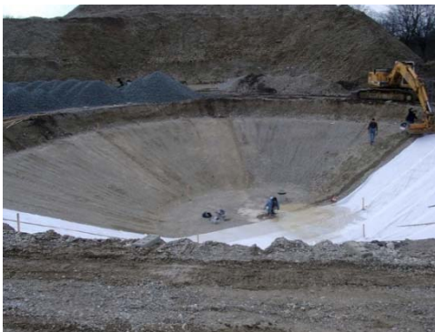
Einbau von 20 cm Schaumglasschotter als untere Dämmlage, Vliesabdeckung
