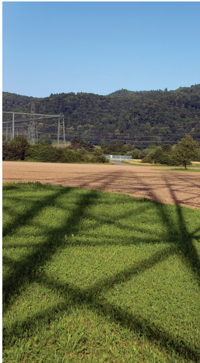
Von Stromleitungen geht nach heutigem Wissen keine wesentliche Gefahr für die Gesundheit der Bevölkerung aus, wie eine Literaturstudie der Forschungsstiftung Strom und Mobilkommunikation zeigt. Foto: Swissgrid
