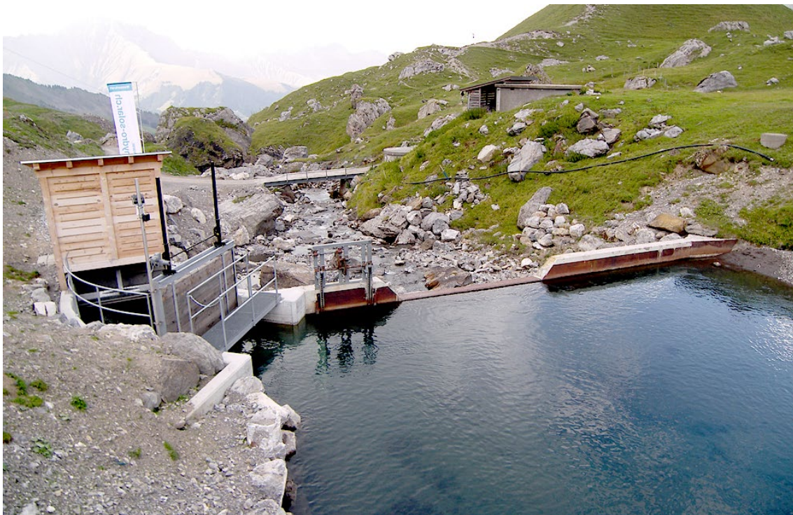
Abbildung 5 Die von der alten Anlage verbliebene Wehrmauer und die Rechenreinigungsanlage links im Bild 12
