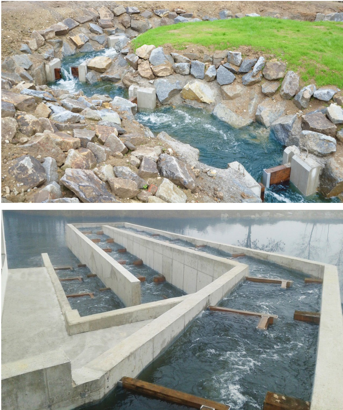
Abbildung 4 Beispiele einer naturnah gestalteten Fischaufstiegshilfe (oben) und eines Beckenpasses (unten) 11
