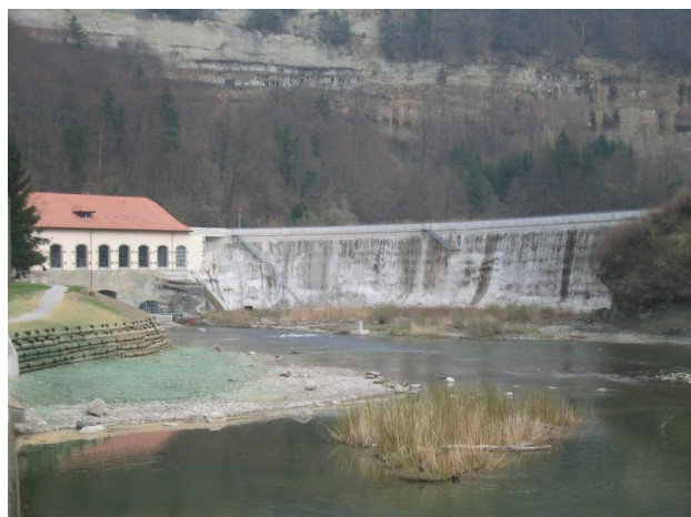
Abb. 8: Europas erste betonierte Gewichtsstaumauer der Mageren Au bei Pérolles südlich von Freiburg, erbaut 1869-1872 und 1910 erweitert [10]
