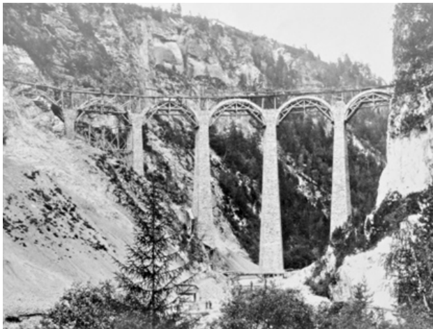
Abb. 5: Landwasserviadukt im Bau, um 1900 [6]
