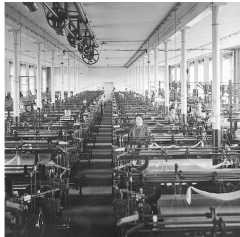
Abb. 6: Oberer Websaal in der Weberei Bleiche in Wald (Kanton Zürich), 1913 [7]
