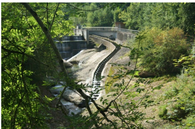
Abb. 15: Fischtreppe des Kraftwerks Soor (Baujahr 2001/2002) [33]
