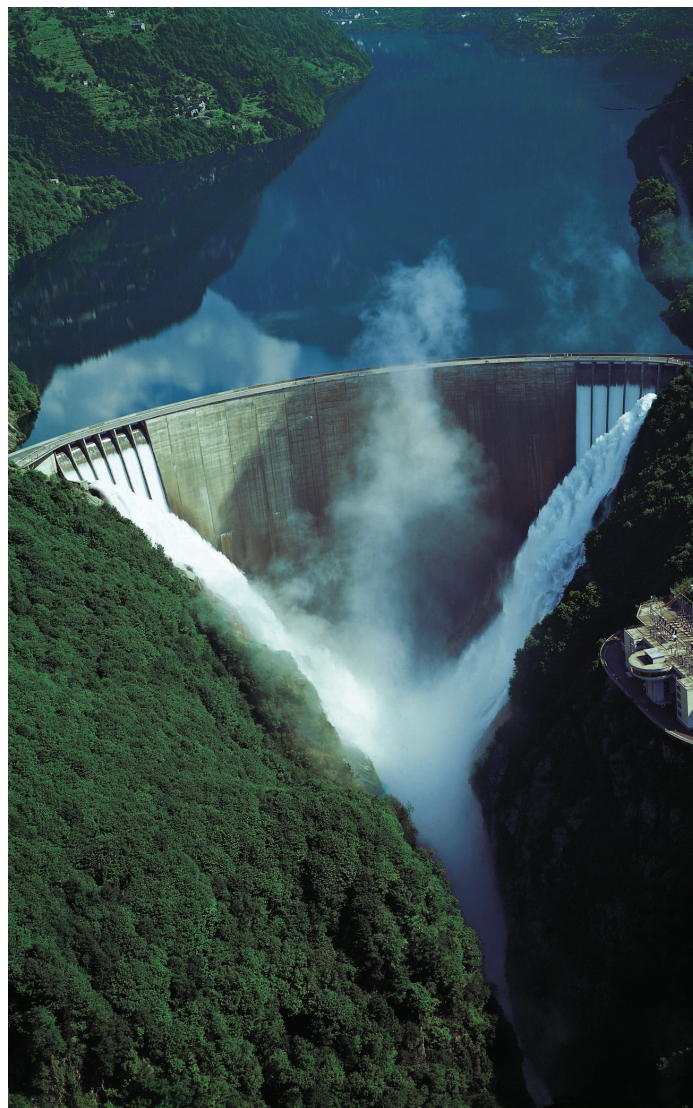
Die Contra-Staumauer im Tessiner Verzasca-Tal wurde in den frühen 1960er Jahren erbaut und ist mit 220 m die vierthöchste Staumauer der Schweiz. Auf beiden Seiten der Mauer sind die zwei Hochwasserentlastungen mit jeweils sechs Schussrinnen erkennbar. Die Hochwasserentlastungen ermöglichen ein Entweichen des Wassers aus dem See, wenn dessen Kapazität ausgeschöpft ist. Foto: SwissCOD, 2011
