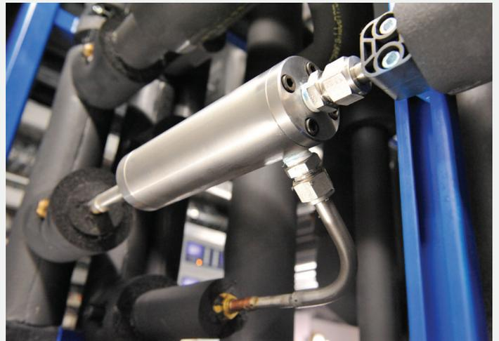
Der Ejektor (Bild) ist ein Bauteil im Kühlkreislauf von Kälteanlagen, die CO<sub>2</sub> als Kältemittel nutzen. Dank des Ejektors und des zugehörigen Parallelverdichters muss die Kühlflüssigkeit weniger stark abgekühlt werden: Für Kühlregale sind nur noch Temperaturen von -2 °C erforderlich (statt -8 °C wie früher), für Tiefkühlregale reichen -25 °C (statt -32 °C wie früher). Damit kann der Kühlkreislauf mit tieferem Stromverbrauch betrieben werden.
