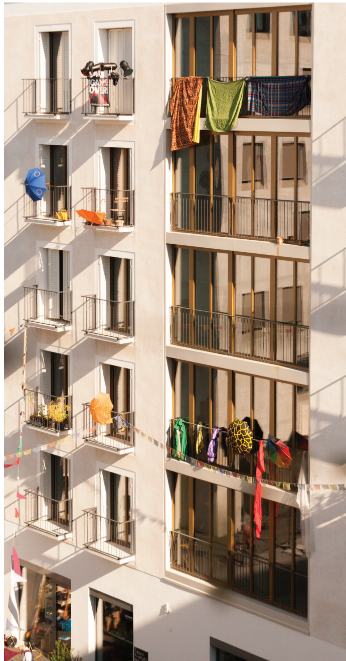
Alle Häuser des Hunziker Areals sind erstklassig gedämmt nach dem Minergie-P-Standard. Foto: Genossenschaft mehr als wohnen
