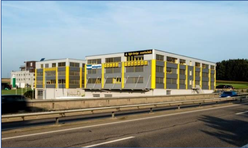
Abbildung 4: Auf dem Bürogebäude der Talus Informatik AG steht eine Solarstromanlage mit 135kWp, deren Produktion zu fast 100% direkt im Gebäude verbraucht wird.
