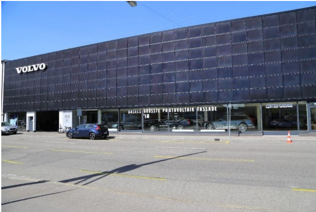
Abbildung 6: Die Volvo Centra-Garage AG besitzt seit März 2016 eine Photovoltaik-Fassade in Basel. Ursprünglich geplant war eine herkömmliche Glasfassade.
