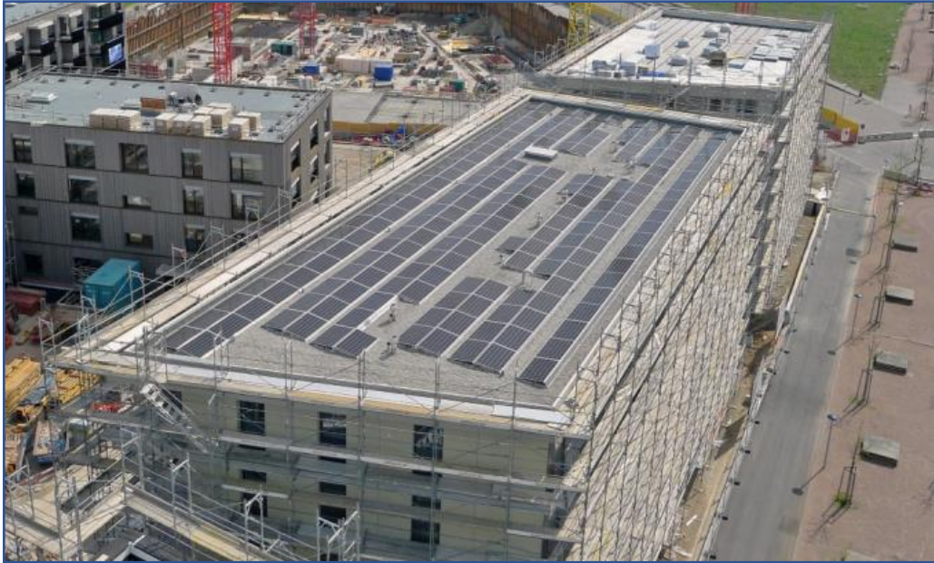
Abbildung 5: Das Neubauprojekt «Erlenmatt Ost» sieht eine Mischnutzung aus Wohnen und Gewerbe vor. Der Strom aus der 850kWp-Solaranlage wird den Bewohnern und Firmen verkauft. Die Messung und Abrechnung des Solarstroms wird durch den Anlagenbetreiber durchgeführt.
