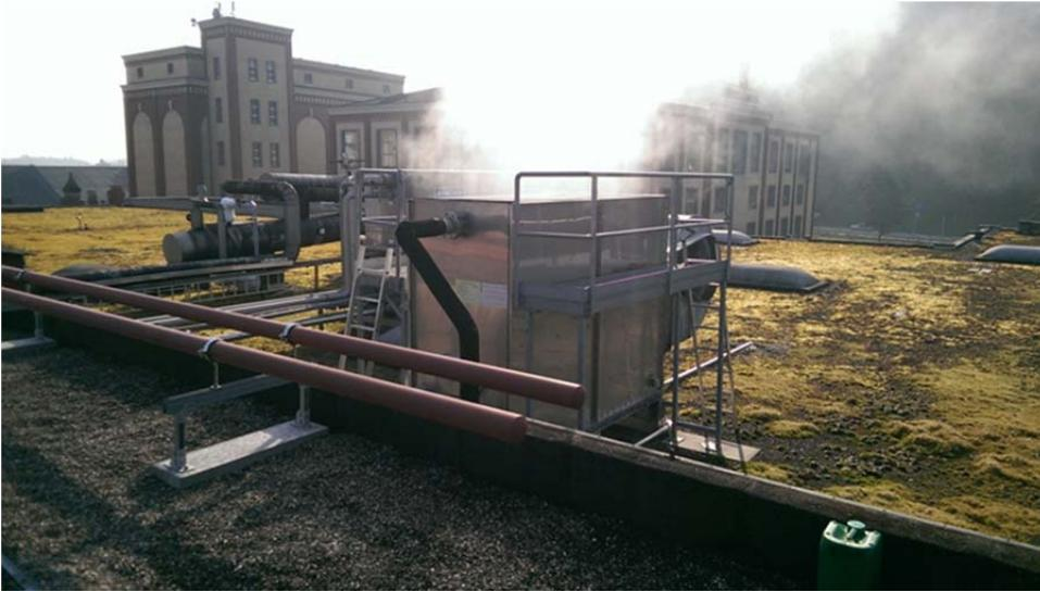
Abbildung 5: Kühlturm und Abwärme-Wärmetauscher
