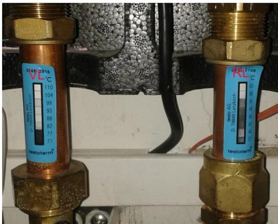
**Abb. 3:** Temperaturmessstreifen im VL und RL des Solarkreises. Nach 4 Wochen zeigt der VL 77°C und der RL 54°C.
