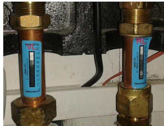
**Abb. 4:** Temperaturmessstreifen im VL und RL des Solarkreises. Eine gezielt erzeugte Stagnation zeigt sich mit 108°C am VL.
