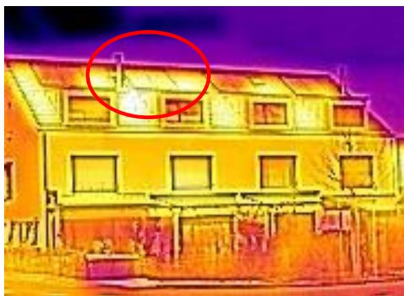
**Abb. 6:** Thermografie von vier Solarkollektorfeldern mit FLIR C2 am 14.4.2015 in Reinach BL. Das zweite Kollektorfeld von links ist überhitzt, da die Temperatur des Kollektorfeldes gleich der Dachtemperatur ist. Wird die Solarenergie korrekt abgeführt, erscheint der Kollektor dunkler als das Dach.
