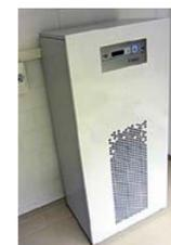
Der Batteriespeicher mit Speicherkapazität von 3,3 kWh. Foto: RG Energietechnik GmbH, Frauenfeld
