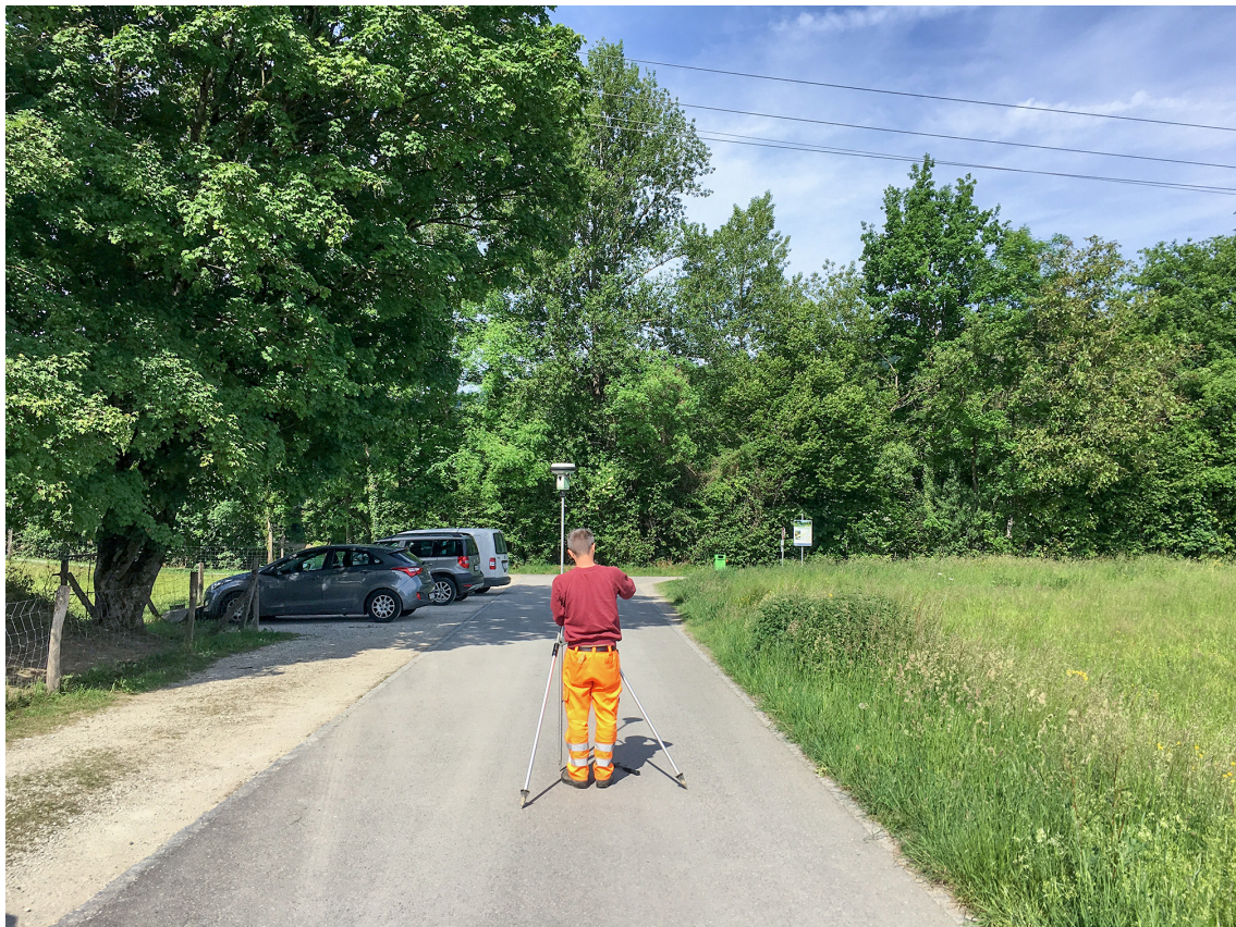
Fig. 5: Die Bohrstelle QBO Gebenstorf-Vogelsang.
