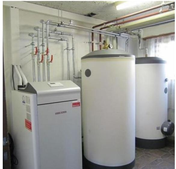
Abb. 4: Leitungen nicht isoliert und kein Thermosiphon in Warmwasserleitung
