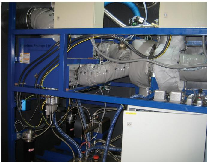
Detailansicht der WKK-Anlage in Düdingen: Die Turbogruppe mit isolierten Zuluft- und Abluftleitungen, Bypassventilen und Öl-Kühlungsleitungen. Foto: Schmid AG
