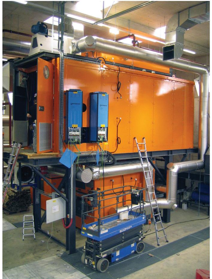
Die Wärme-Kraft-Kopplungsanlage mit Heissluftturbine in der Energiezentrale der Fernwärme Düringen. Foto: Schmid AG
