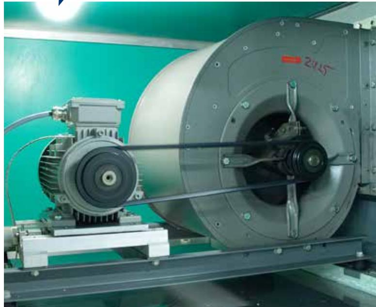
**ERSATZ DER LÜFTUNGSMOTOREN**
