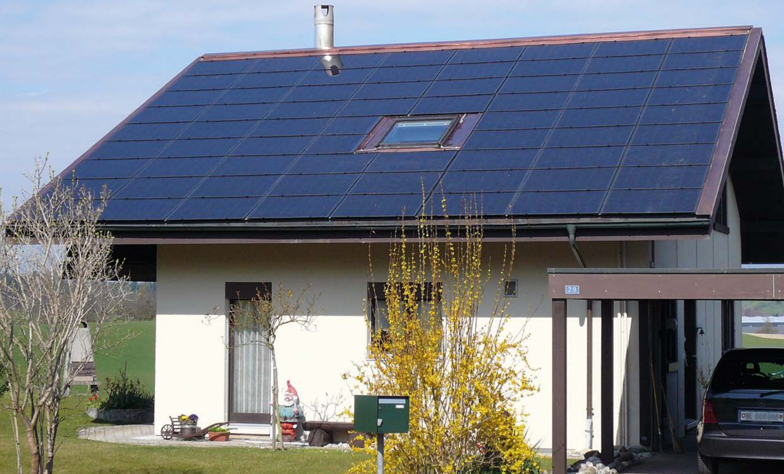
Dachintegrierte PV-Anlage auf einem Einfamilienhaus
