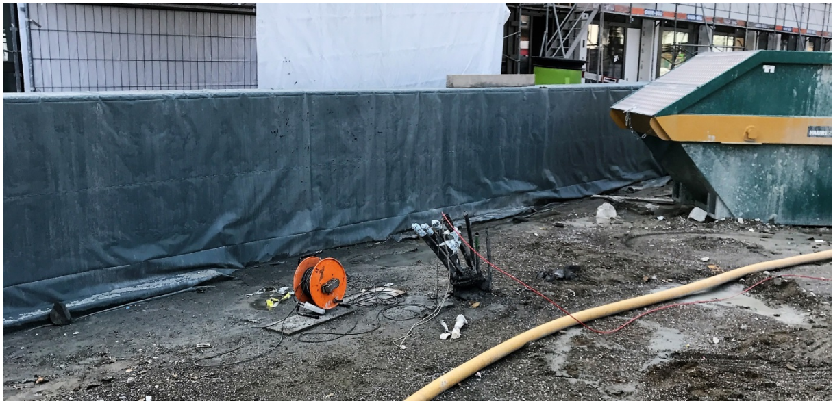
Abb. 13: Erdwärmesondenkopf von EWS 8 (Aufnahme vom 2.03.2017)
