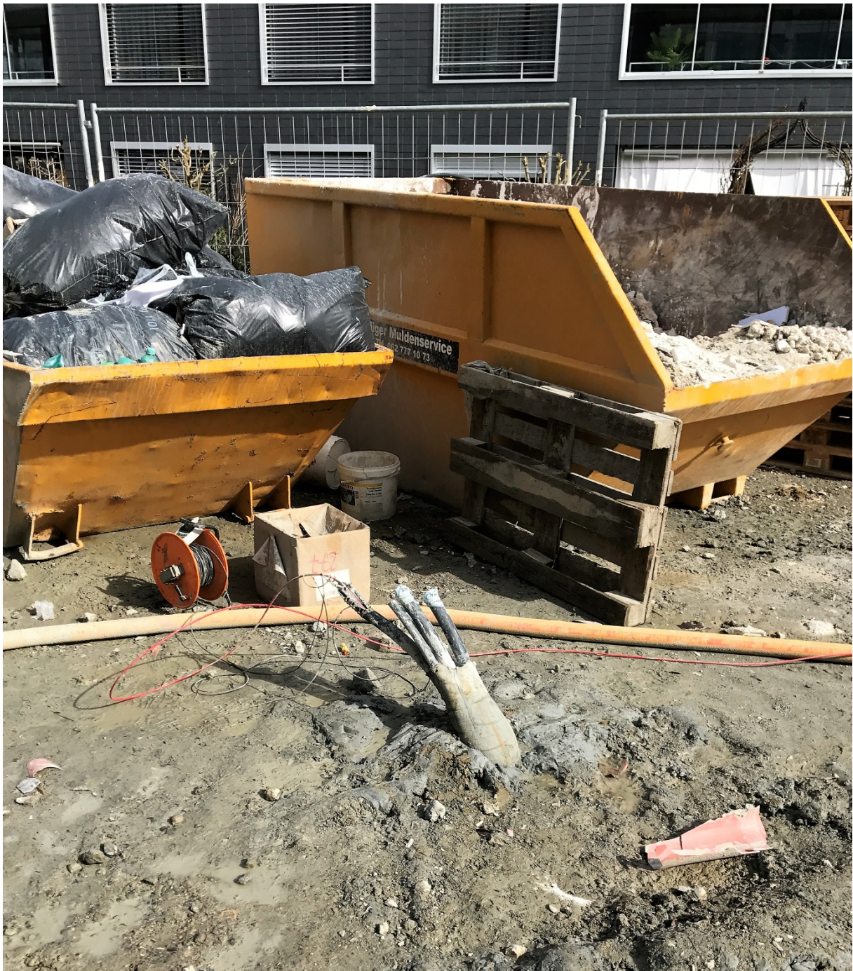
Abb. 17: Übersicht der Messung von EWS 6 (Aufnahme vom 3.03.2017)
