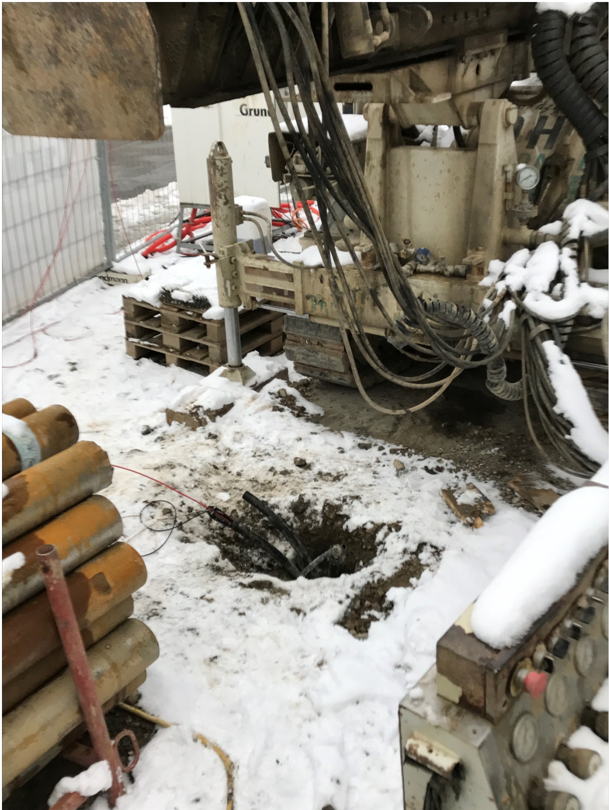
Abb. 6: Erdwärmesondenkopf von EWS 11 (Aufnahme vom 9.01.2017)
