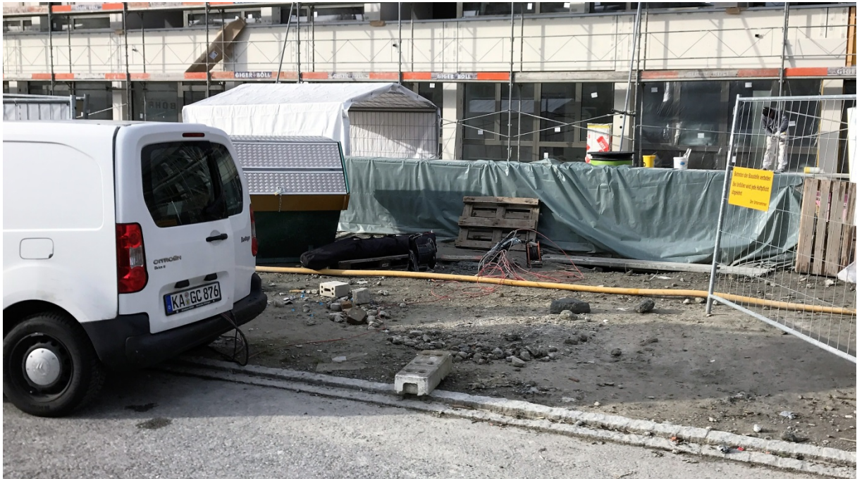
Abb. 15: Übersicht der Messung von EWS 7 (Aufnahme vom 3.03.2017)
