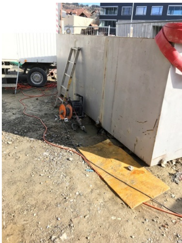
Abb. 11: Auf dem Erdwärmesondenkopf von EWS 11 war ein Container mit Spülflüssigkeit gestellt (Aufnahme vom 2.03.2017)
