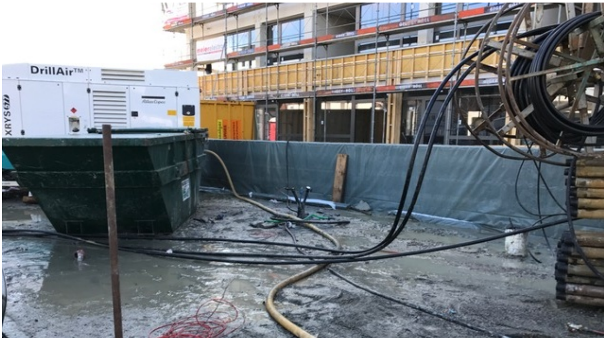
Abb. 9: Erdwärmesondenkopf von EWS 9 (Aufnahme vom 6.02.2017), mittig im Bild. Rechts im Bild ist die Haspel mit den Sondenrohren für eine weitere Bohrung zu sehen.
