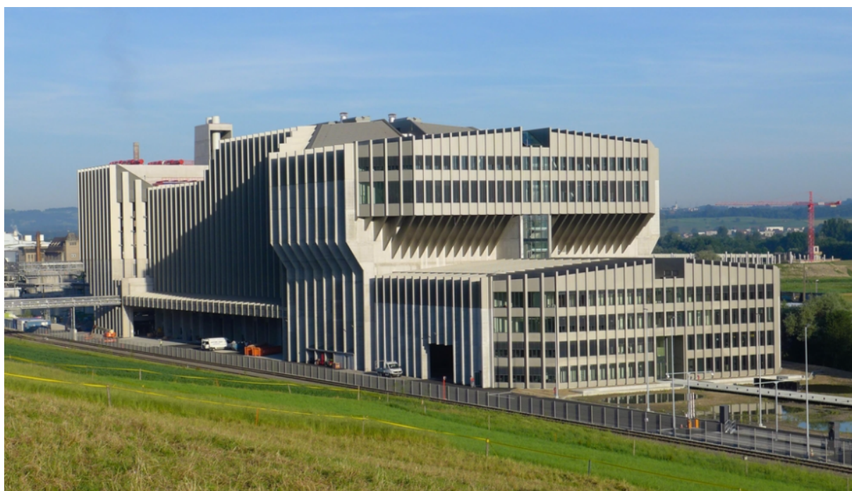
Abbildung: Renergia, KVA Perlen: 2016 ist das erste Jahr im Vollbetrieb (Quelle: Renergia)
