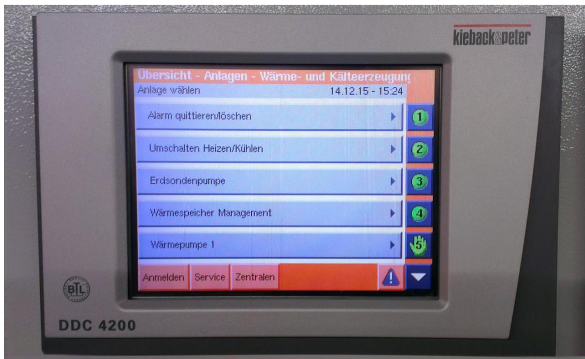
Abbildung 5: Display der Anlagenautomation
