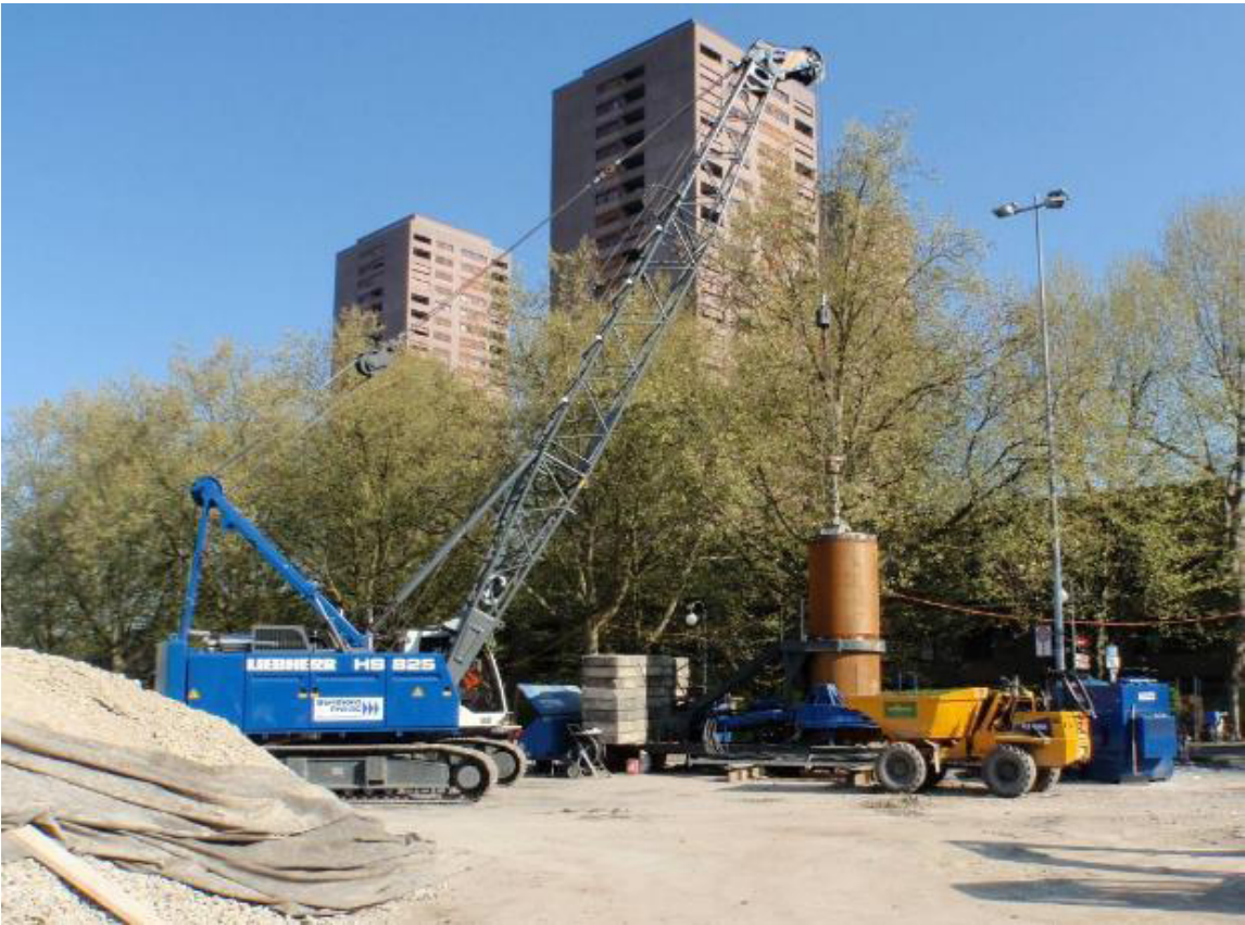
Abbildung 13: Brunnenbau, Energiezentrale Hardau II, Zürich (Quelle: Jäckli Geologie).
