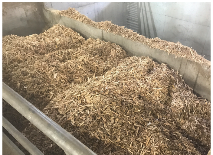
Das Holzvergasungs-WKK in Stans (NW) nutzt naturbelassenes Abfallholz für die Energieerzeugung. Foto: B. Vogel
