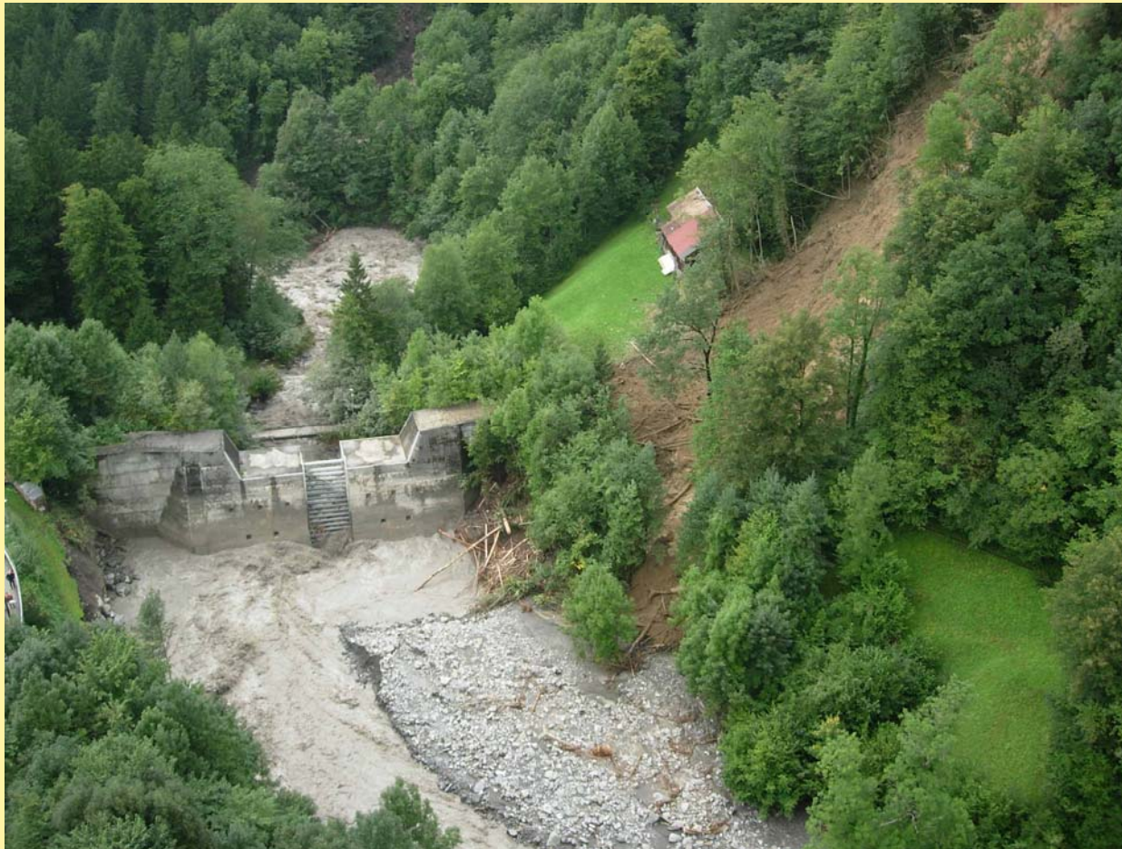
Geschiebesammler Stiglisbrücke, Bürglen beim HW August 2005
