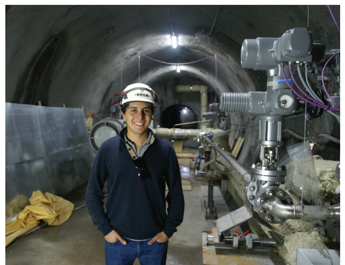
Projektleiter Giw Zanganeh vor der Anlage, mit der der adiabatische Kompressor simuliert wird. Hinten in der Bildmitte: Eingang zur Druckkammer. Foto: B. Vogel
