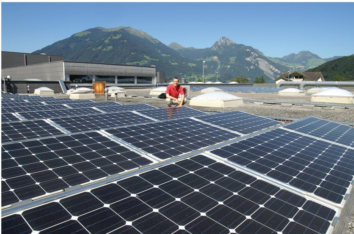
Jürg Rohrer, Professor für Ecological Engineering an der ZHAW in Wädenswil, hinter den PVT-Solarmodulen auf dem Dach der Lintharena sgu in Näfels (GL), die sowohl Strom als auch Wärme produzieren. Im Hintergrund: PV-Module zur Stromerzeugung (von aussen sehen sie identisch aus wie die PVT-Module). Foto: B. Vogel
