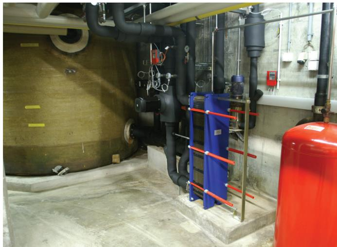
Der Wärmetauscher (blau) nimmt die Wärme aus dem Solar-Kreislauf auf und führt sie dem Grundwasser zu, das im Grundwassertank (braun) gespeichert ist. Foto: B. Vogel
