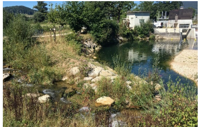
Mündung des Umgebungsgewässers für den Fischaufstieg bei der Zentrale Grand Ecluse (siehe auch Mitteilungen, Foto: SID)
