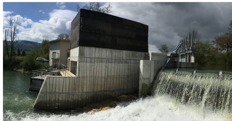
Kraftwerk Grande Ecluse in Delémont (JU)
