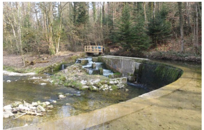
Beckenschlitzpass am Arnon bei der Moulin de Péroset (Fiez, Waadt, Foto: Mhylab)
