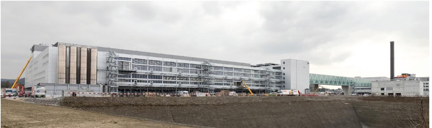
Der Neubau im Coop-Verteilzentrum in Schafisheim (AG) beherbergt 23 Prozesslinien für die Herstellung von Bäckerei- und Konditoreiwaren. Die Öfen werden mit Thermoöl geheizt, das in der Energiezentrale (rechts mit Kamin) durch eine innovative Biomassefeuerung erhitzt wird. Foto: Coop
