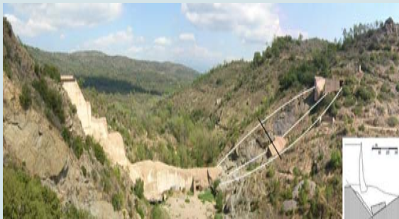
Malpasset (F), Fundationsversagen beim ersten Vollstau
