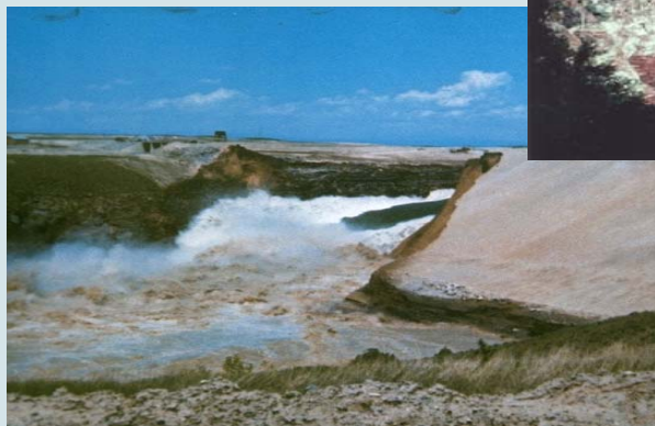
Teton Damm, (USA) Innere Erosion
