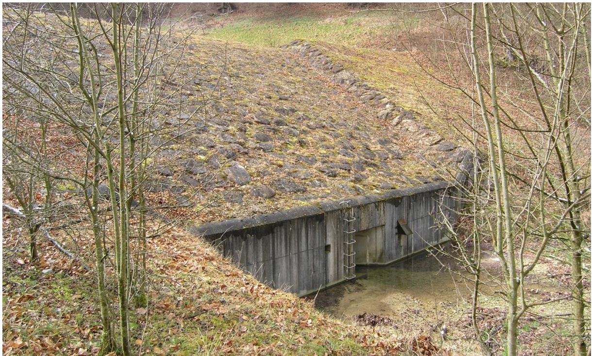
Stauanlage Eimatt (BL)
