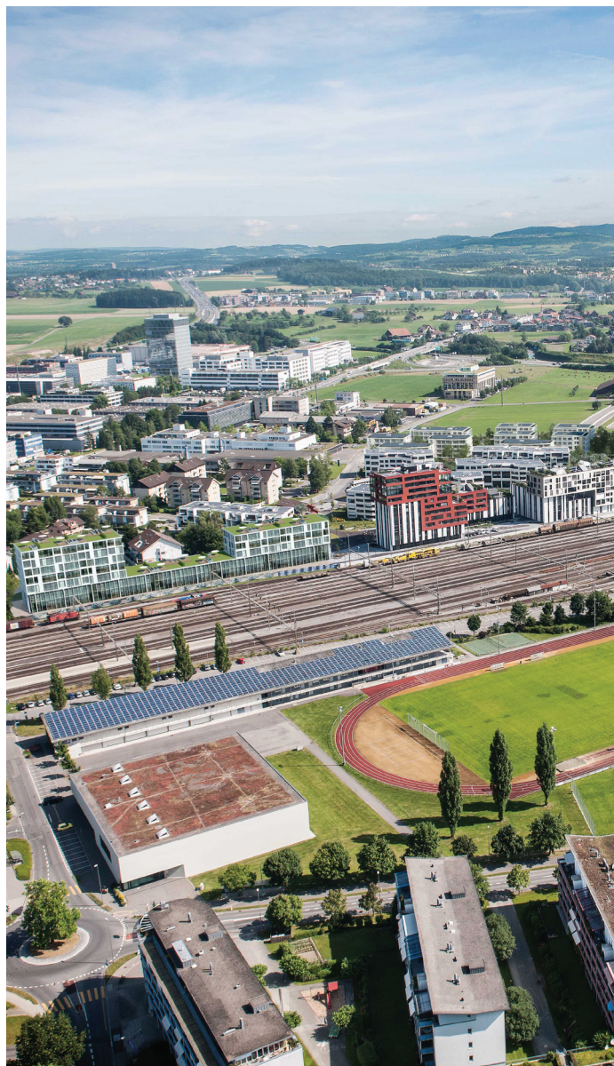
Ein Anergienetz versorgt die Suurstoffi-Überbauung nördlich des Bahnhofs Rotkreuz mit Heizwärme, Warmwasser und Kälte. Foto: Zug Estates AG
