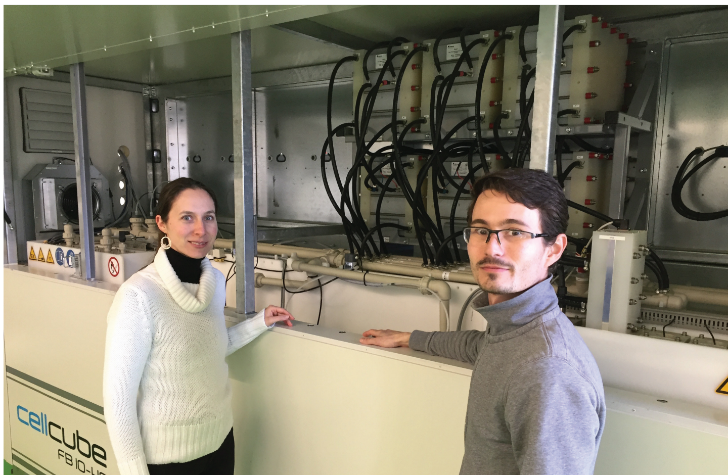
Dr. Véronique Amstutz und Dr. Heron Vrabel vor der Redox-Flussbatterie im EPFL-Forschungslabor in Martigny. In den sechs Tanks im Hintergrund findet der elektrochemische Prozess statt, bei dem der positive und der negative Elektrolyt ge- bzw. entladen wird. Foto: B. Vogel
