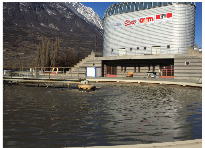
In diesem Gebäude neben der ARA von Martigny haben Wissenschaftler der ETH Lausanne erforscht, wie sich eine Redox-Flussbatterie direkt zur Herstellung von Wasserstoff nutzen lässt. Foto: B. Vogel
