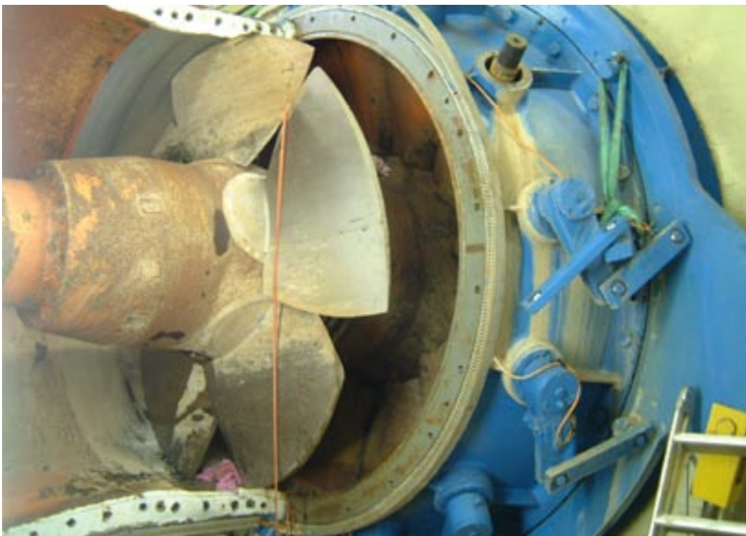
Die Kaplan-S-Turbinen der beiden Kraftwerke waren noch in gutem Zustand.
