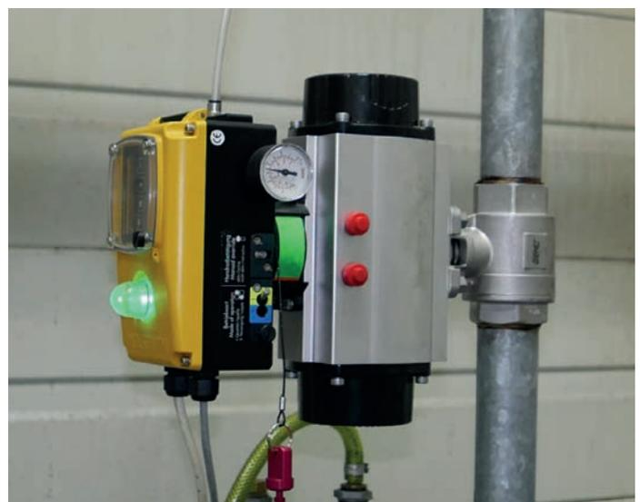
Das automatische Abkoppeln des Leitungsnetzes ausserhalb der Betriebszeiten durch einen elektrisch gesteuerten Kugelhahn ist ein lohnendes Sparpotenzial. Es verhindert wirkungsvoll Leckageverluste, die zu 95% nach der Druckluftzentrale auftreten.
