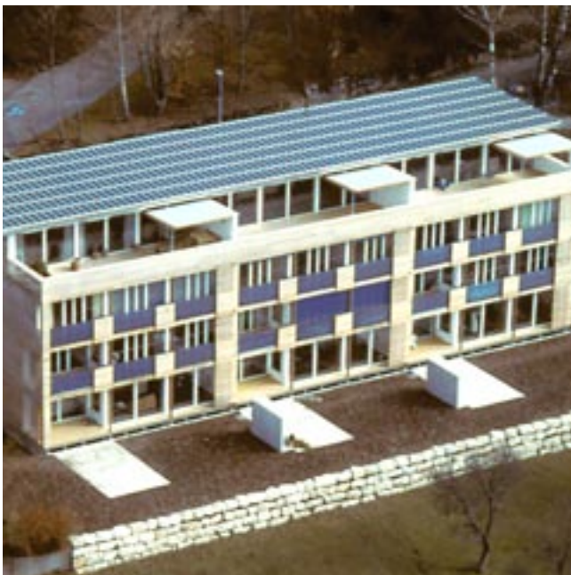
Beim Mehrfamilienhaus «Sunny Woods» in Zürich-Höngg ist eine PV-Anlage mit Dünnschichtsolarzellen ins Pultdach integriert. (Bild Lieni Hofmann)
