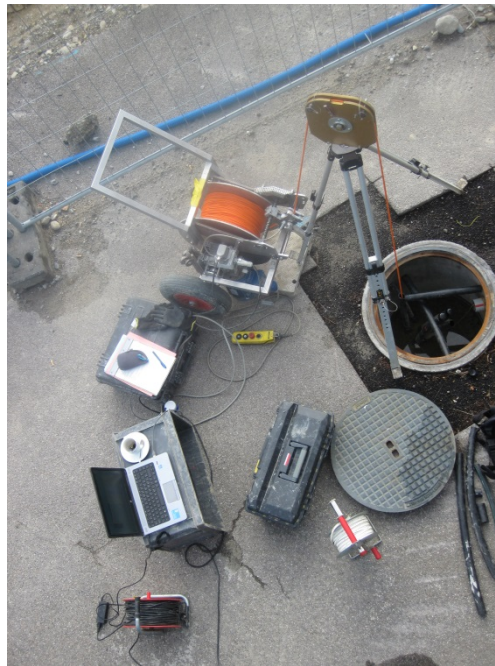
Abbildung 5: Deepdrifter ® im Einsatz bei der EWS-Versuchsanlage (Quelle: Eberhard & Partner)
