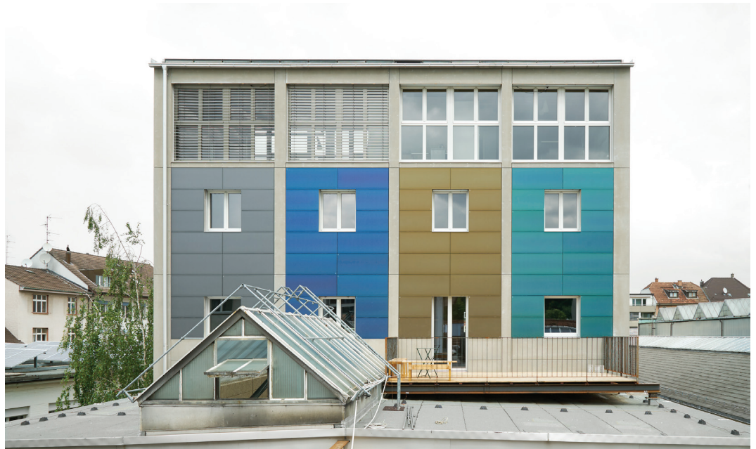
PV-Module in Grau, Blau, Gold und Türkis an der Fassade des umgebauten Kohlesilos im Basler Gundeldinger-Quartier. Foto: Martin Zeller
