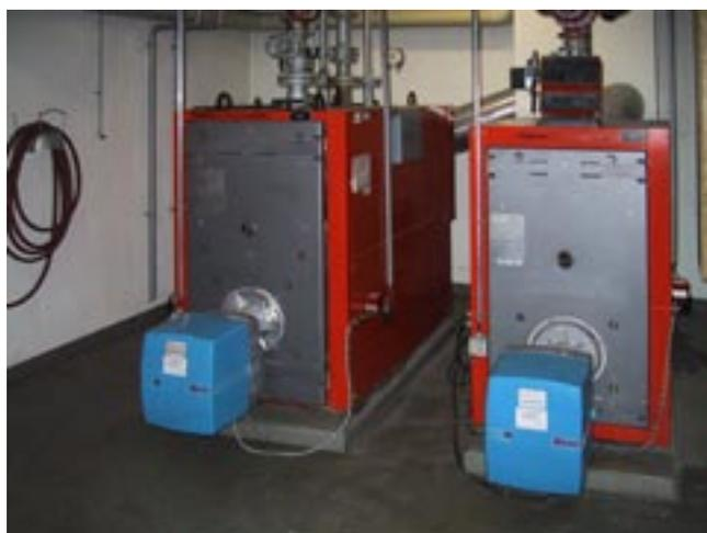
Die beiden Heizkessel arbeiten nach der Optimierung als Kaskade.
