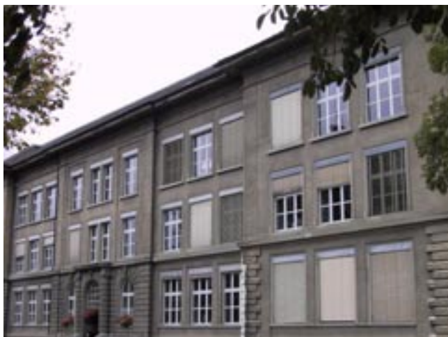
Das Stadtschulhaus Emmersberg ist in einem Wärmeverbund mit der Kantonsschule und einer Turnhalle.
