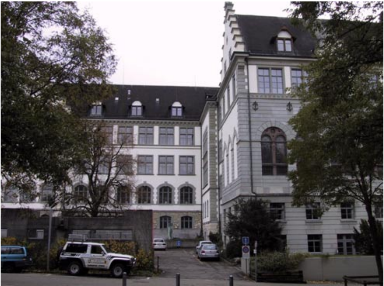
Bei der Kantonsschule Schaffhausen sollte die Gebäudearchitektur durch die energetische Sanierung nicht verändert werden.
