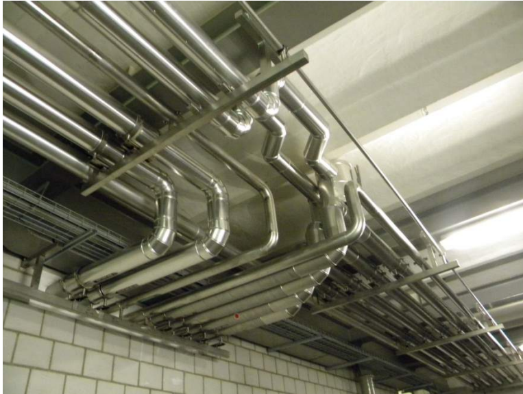
Neue Versorgungsleitungen Glykolkälte für Gebäudeteil Nord ab Kälteanlage 2.
