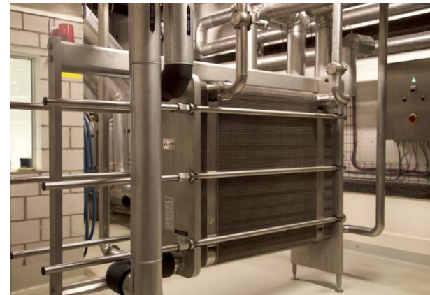
Versorgung der Kurzzeiterhitzungsanlage für Bier in Tankfahrzeugen und der Eiswasseranlage zur Versorgung des Technikums.
