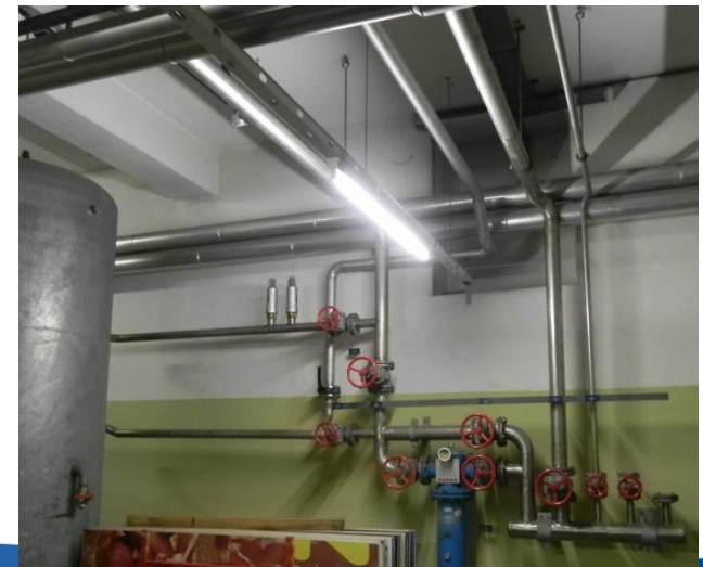
Systemeinbindung druckluft- & kühlwasserseitig
