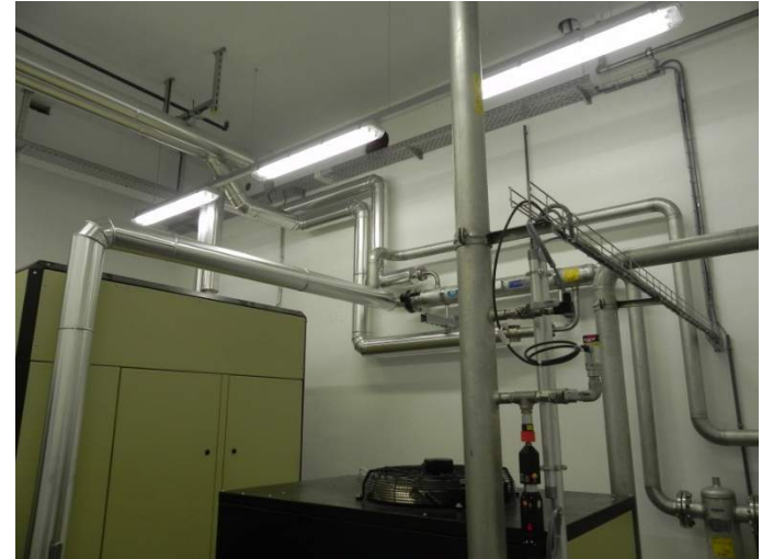
Systemeinbindung druckluft- & kühlwasserseitig
