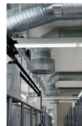
Die Druckerei von Ah saugt die warme Luft über den Druckmaschinen ab und heizt damit das ganze Gebäude.
