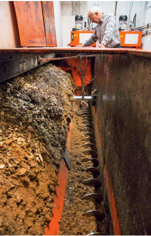
Zufuhr zur Schnitzelheizung
