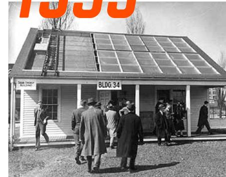
«Solarhouse I», eine Art Ökohaus-Vorläufer und 1939 erbaut durch **Hoyt Hottel**, stand als Versuchslabor auf dem Campus des Massachusetts Institute of Technology (MIT). Es war das erste durch aktive Sonnenenergie beheizte Haus, mit einem vierfach verglasten thermischen Solarkollektor auf dem Dach. Die Sonnenstrahlung wurde im Winter als Wärmequelle genutzt und im Sommer zur Stromerzeugung für eine Klimaanlage.
