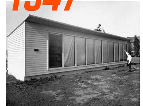
«Solarhouse II» wurde im Jahr 1947 ebenfalls am MIT errichtet. Die Wärmekollektoren in Form von schwarz lackierten gestapelten Dosen wurden nicht auf dem Dach, sondern an der nach Süden ausgerichteten Wand montiert. Das Labor war unterteilt in sieben Sektoren, die jeweils durch eine unterschiedliche Anzahl und Art von Wärmekollektoren beheizt wurden. Strom wurde ausschliesslich für einen Umluftventilator verwendet. Das «Solarhouse II» krankte an einem hohen Wärmeverlust in Winternächten.
