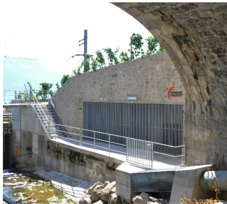
Kleinwasserkraftwerk Rivaz am Forestay, am Ufer des Genfersees (© Romande Energie)
