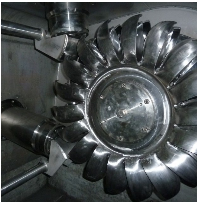
Trinkwasserkraftwerk in Plan Sépey: Peltonrad, Guss (Foto: J-M Chapallaz)
