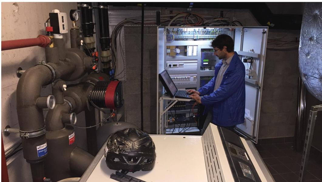
*Mit einem ausgeklügelten Messsystem aus Glasfasern kann Projektleiter Francesco Barone die Temperatur entlang der Erdwärmesonden, die an zentraler Lage in Lausanne 500 Meter tief verlegt wurden, exakt ermitteln. Foto: B. Vogel*
