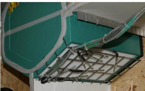
Abbildung 5: Temperaturmessstelle auf der Fortluftseite
