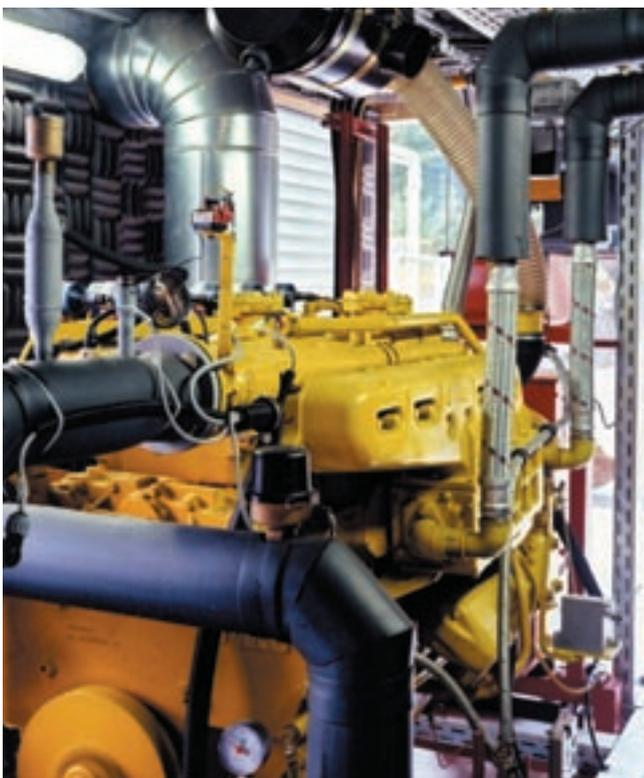
Im Blockheizkraftwerk wird aus Biogas Wärme und Strom erzeugt.
